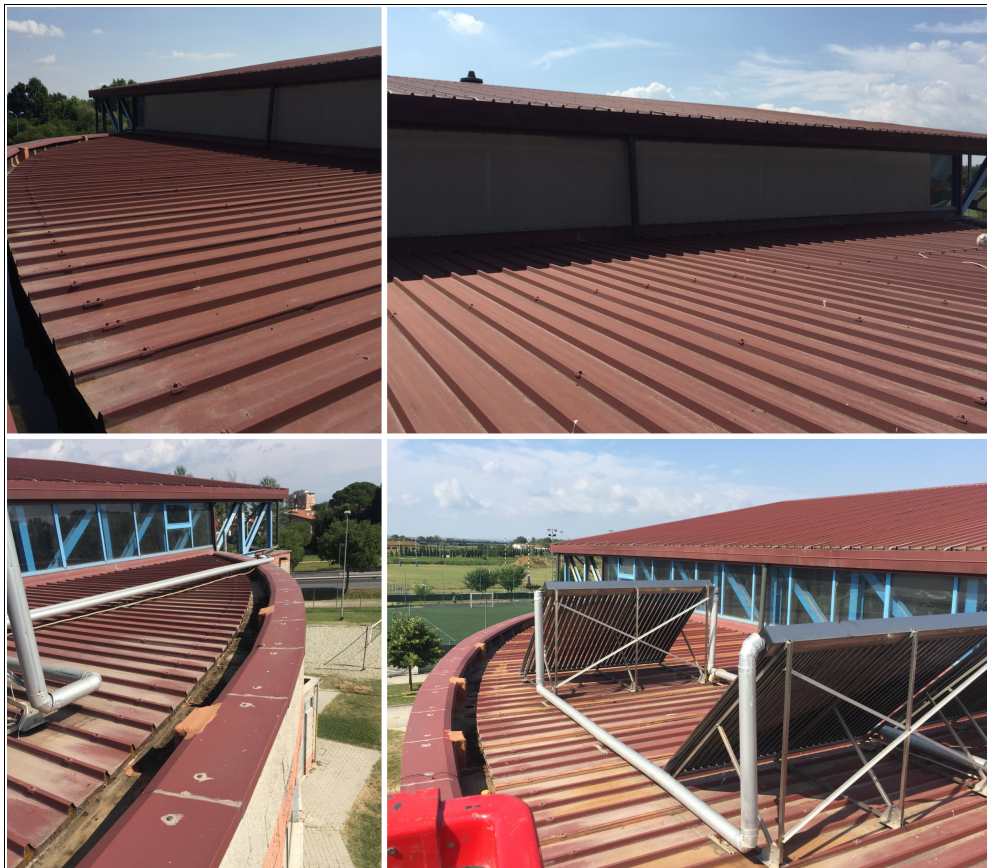
Fig.3: Viste della copertura dei corpi di fabbrica laterali
