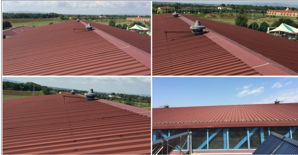
Fig.2: Viste della copertura del corpo di fabbrica centrale
