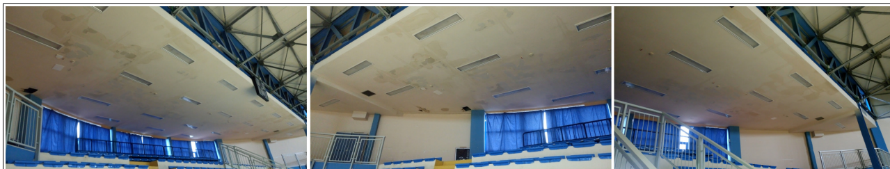
Fig.4: Area tribuna interessata dalle infiltrazioni - edificio lato ovest
