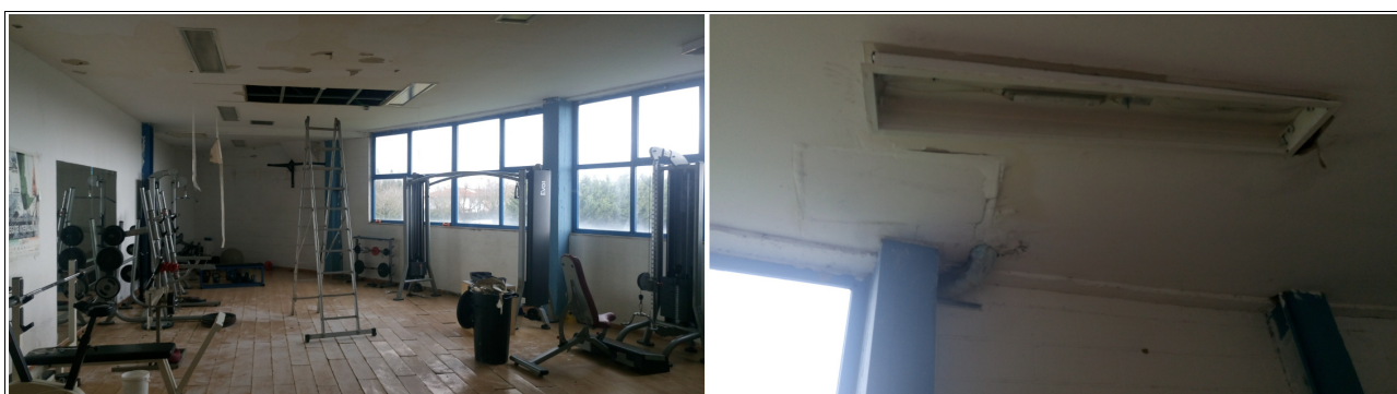
Fig.5: Area locale attività ginnica interessata dalle infiltrazioni - edificio lato est
